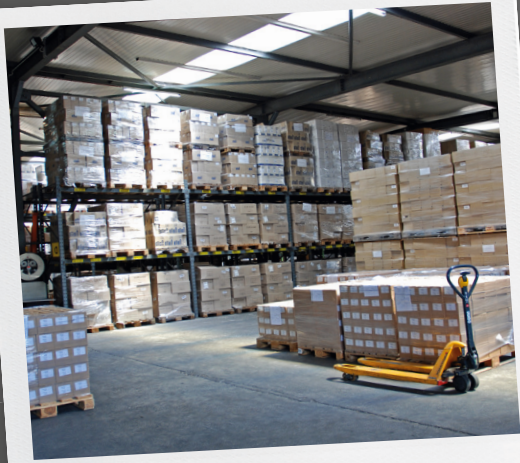
... riscaldamento di magazzini
