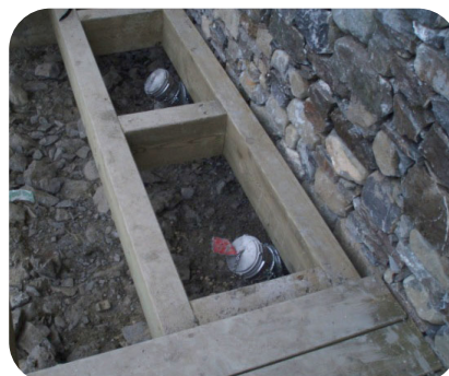
Raccords sous le niveau du sol
