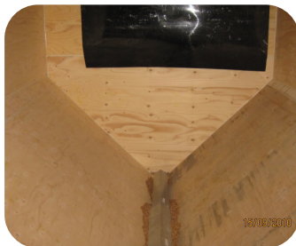
Pans inclinés en OSB avec pointe de diamant en fond de vis (à gauche) ou pans inclinés en planche contre-plaqué (à droite).
