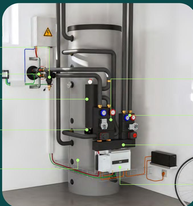
**Kit de raccordement hydraulique pour la pompe à chaleur**
