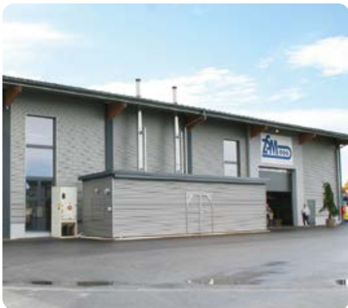
Das Firmengebäude der Z-S-M Maschinen & Metallbau GmbH wird von einer ÖkoFEN-Heizzentrale mit 224 Kilowatt versorgt.
