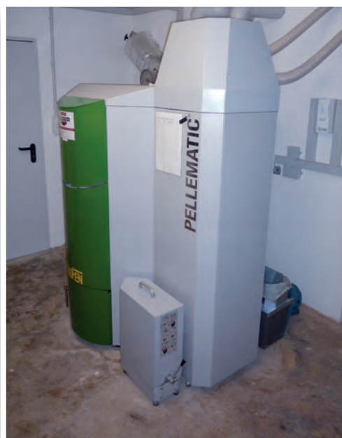
Diese 48 kW Pelletsheizung passt sich automatisch an den aktuellen Energiebedarf des Rathauses an.
