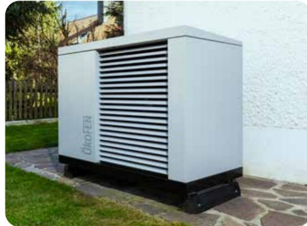
Im Sommer und in der Übergangszeit sorgt nun die Wärmepumpe in Verbindung mit der vorhandenen 14 kW Photovoltaik-Anlage und einem 20,3 kWh Batteriespeicher für einen überwiegend autarken, umweltfreundlichen und kostengünstigen Betrieb. Im Winter beheizt der Pelletkessel das Einfamilienhaus.
