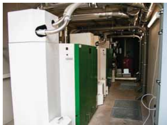
4 Pellematic Maxi in cascade. 256kW
