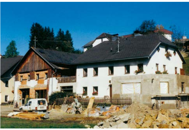
Es begann im Jahr 1989 in einem Kuhstall in Lembach. Hier zu sehen die ersten Umbauarbeiten am jetzigen Standort Mühlgasse in Lembach im Jahr 1996.
