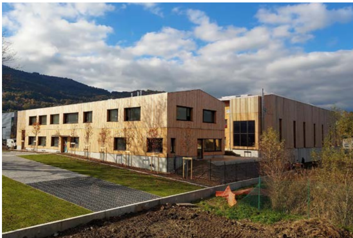
Bild links: Aktueller Stand der Bauarbeiten bei ÖkoFEN Frankreich; Bild rechts: Geplante Logistikhalle im bayerischen Mickhausen
