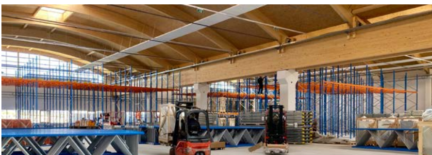
Aufbauarbeiten der Regale im März 2020
