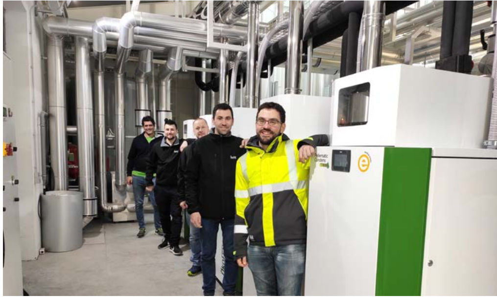
ÖkoFEN Kundendiensttechniker aus Österreich und Spanien bei der Inbetriebnahme.
