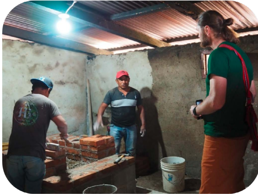
Bei der Projektreise im August 2025 zeigen die Ofensetzer Martin Berndorfer (Sei So Frei) wie der Holzsparofen mit einfachen Mitteln vor Ort gebaut wird.
