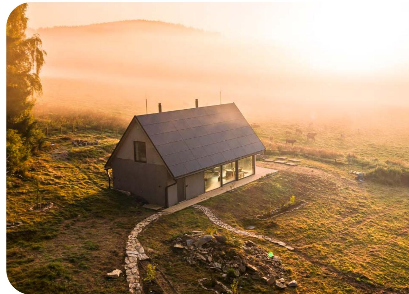
Die Stromversorgung übernimmt eine Photovoltaikanlage mit 15 kWp, welche die gesamte nach Süden ausgerichtete Dachfläche einnimmt.
