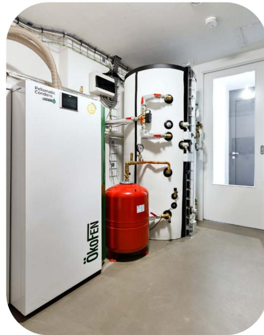
Für Wärme und Warmwasser sorgen ein ÖkoFEN Pellematic Condens, 8 kW und ein 1.000-Liter-Warmwasserspeicher. Durchschnittlicher Pelletsbedarf für 116 m<sup>2</sup> Wohnfläche: 600 kg/Jahr.
